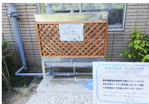
長野保健福祉事務所へのタンク設置状況
