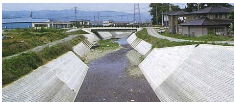
河川改修工事後
