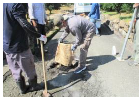
農道補修作業
